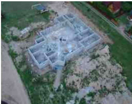
Rys 3. Budowa z lotu ptaka
