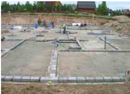
Rys 2. Przygotowania do murowania ścian
